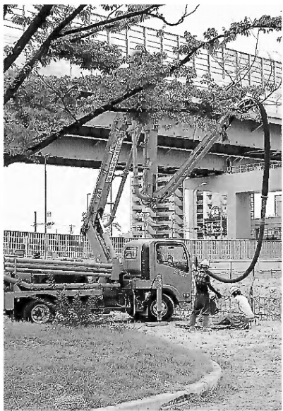
港明公園で始まった中川学童保育所のプレハブ建設工事(2日)
